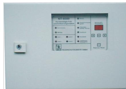
FSG-NASS/TROCKEN-STATION NT-6800R DVGW-Nr.: NW9910BQ0291
